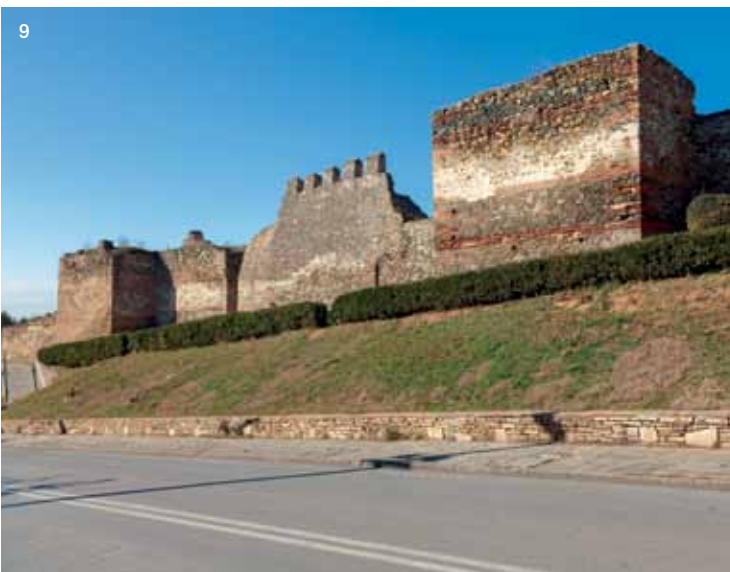
9. Άποψη των ανατολικών τειχών της Θεσσαλονίκης.
